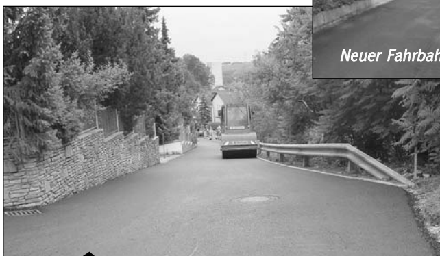
Neuer Fahrbahnbelag in der »Sonnfeldsiedlung«.
