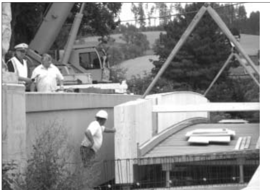
Bürgermeister Wolfgang Großruck und Postenkommandant Johann Eiblhuber beobachten den Baufortschritt
