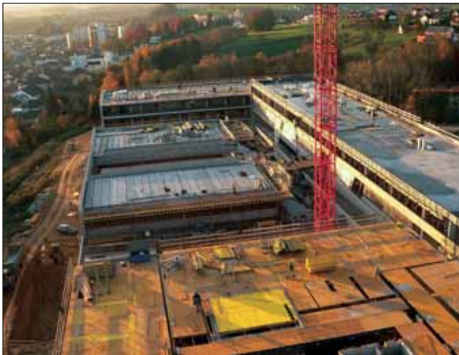
im Vordergrund: Schalungsarbeiten für letzte Geschoßdecke HTL; mittig: Dachlückenschluss bei 3fach-Turnhalle; im Hintergrund: Dachdeckerarbeiten an der HS II; beim rechten, langgezogenen Gebäudeteil handelt es sich um die HS I
