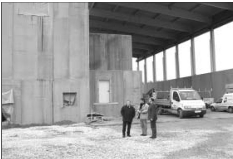
Das neue Bioheizwerk Grieskirchen-Parz – ein architektonisch in die Landschaft passendes Betriebsgebäude, das in seiner Konzeption nach außen verspricht, was es innen hält: Produktion von Wärme durch saubere nachwachsbare heimische Energie. Bürgermeister Wolfgang Großruck, Geschäftsführer Hans Wildfellner und Fröling-Betriebsleiter Ing. Johann Hochstöger freuen sich über die Inbetriebnahme dieser Anlage.
