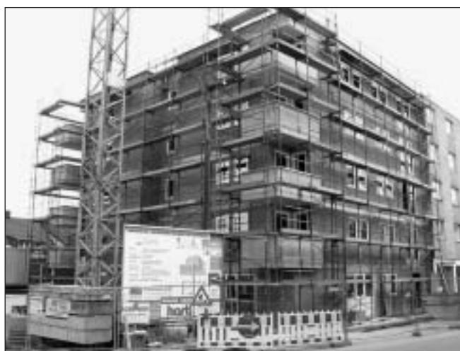
Baufortschritt Mai 2005 - Der Bau schreitet zügig voran
