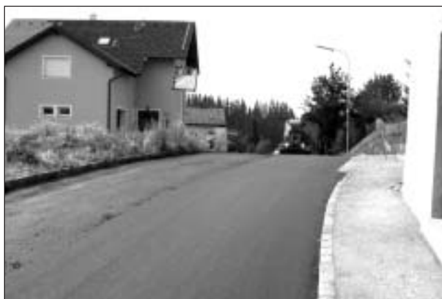
Sanierung der schadhaften Kalvarienbergstraße
