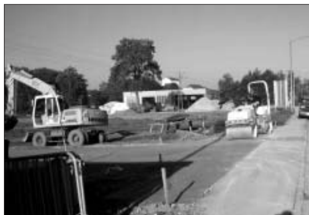
Hier entsteht die Aufschließungsstraße für das neue Altstoffsammelzentrum
