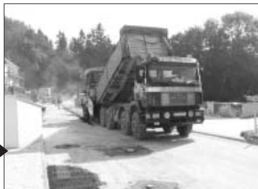
Ausbau der Eichenstraße, 1 Teil
