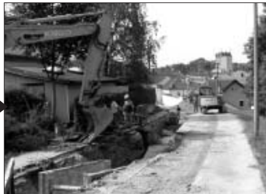
Kanal- und Wasserleitungsbau in der Gymnasiumstraße in Zusammenhang mit der Infrastrukturschaffung für das neue Schulzentrum.
