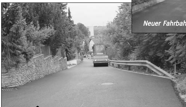
Neuer Fahrbahnbelag in der »Sonnfeldsiedlung«.
