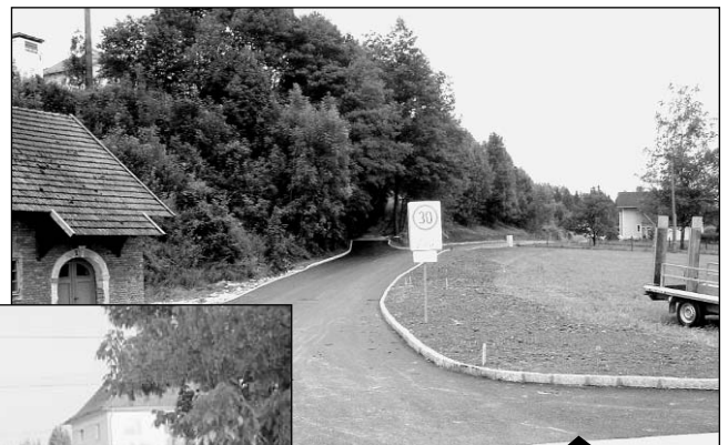
Staubfreimachung der »Bachstraße«.
