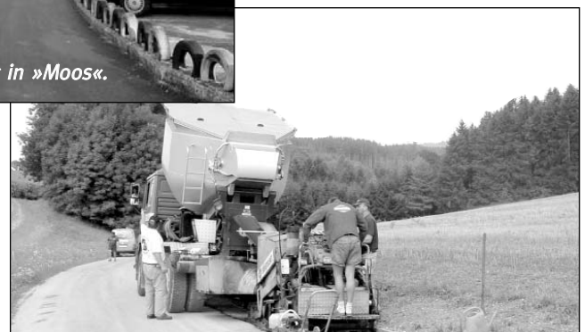
Wiederherstellung des Fahrbahnbelags nach Einbau einer Entwässerung in »Schamosberg«.
